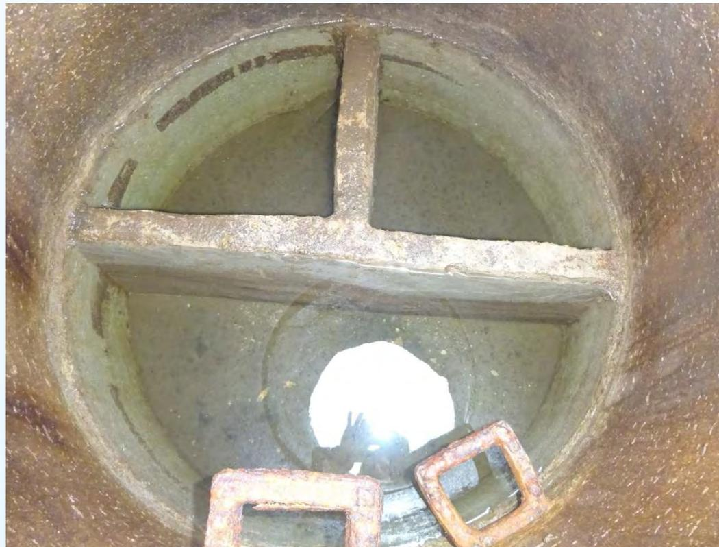
Dreikammergrube ohne Funktion (kein Zu- und Ablauf, keine Verbindung zwischen Kammern)
